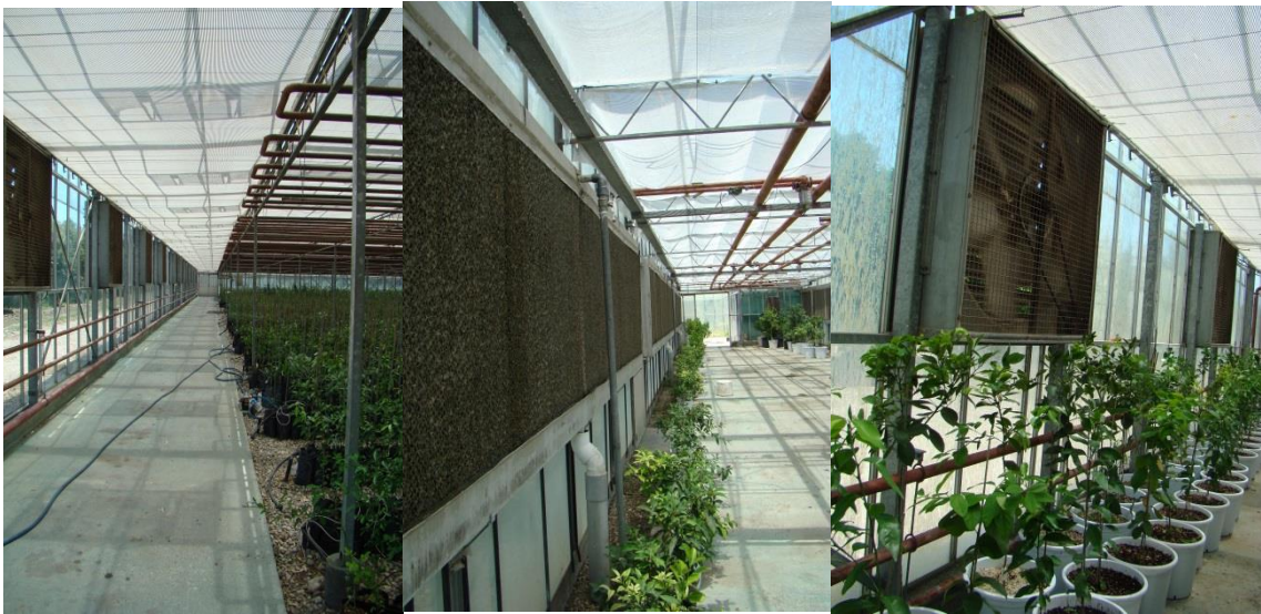
Resim-16.Seralarda ısı ve nem kontrolünü sağlayan ısı perdesi, nem pedleri ve fanlar
