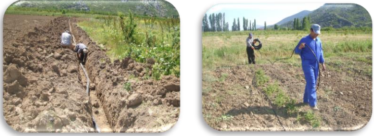
Şekil 10. Yağ gülü bahçelerinde damla sulama sisteminin kurulması
